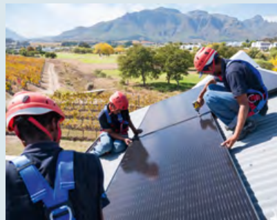
Flexible Microgrids erzeugen aus Solarenergie Wasserstoff.
