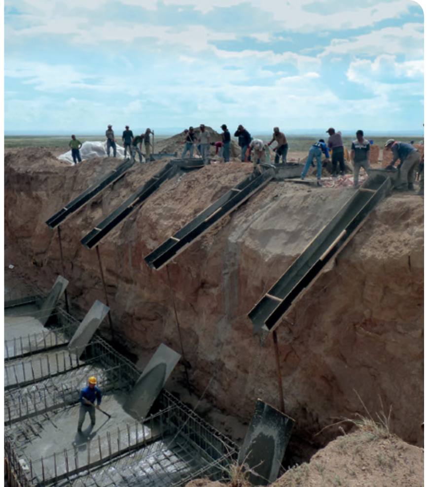
Bau einer Kläranlage in Teshig Soum, Provinz Bulgan.
