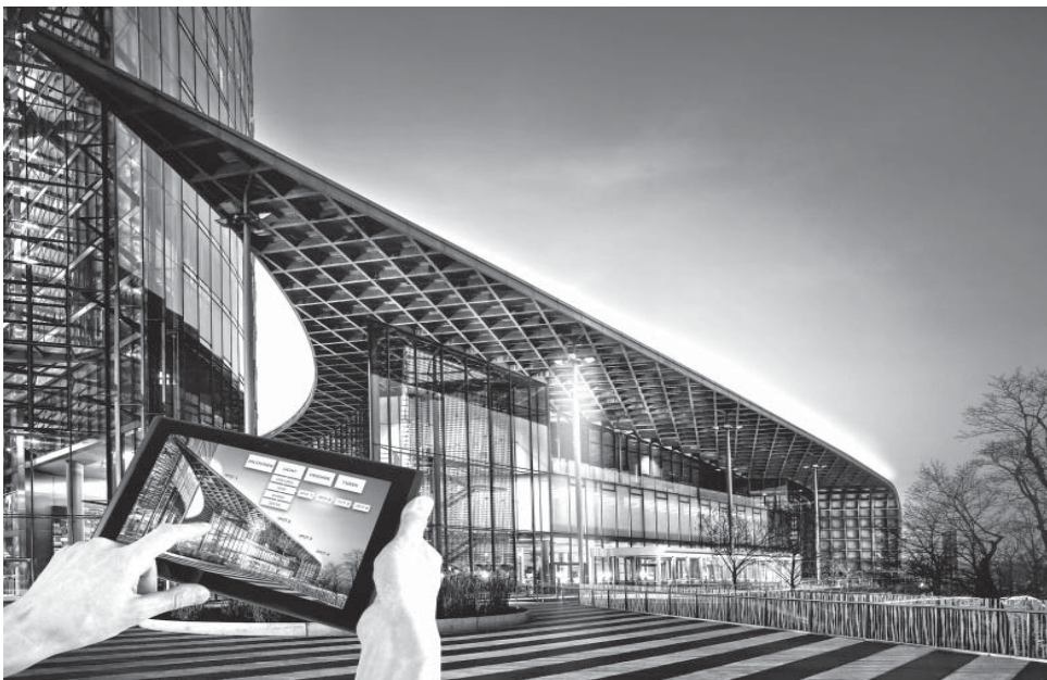
Gebäudemanagement mit dem Tablet: In vielen modernen Bürohäusern lassen sich Licht, Jalousien oder Türen zentral über das Internet steuern. Das bringt Effizienzgewinne, birgt aber auch Gefahren. (© Fraunhofer FKIE) | Bild in Farbe und Druckqualität: www.fraunhofer.de/presse
